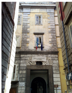
Das Eingangportal zum heutigen Konservatorium in Neapel. (Bild: Wikimedia Commons).
